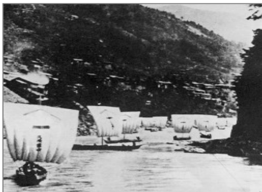
出所：天竜川写真館
